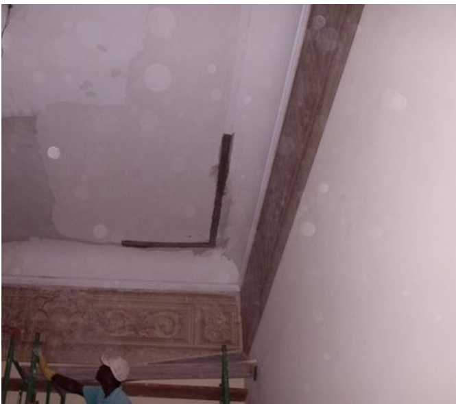
Serviço em execução.
