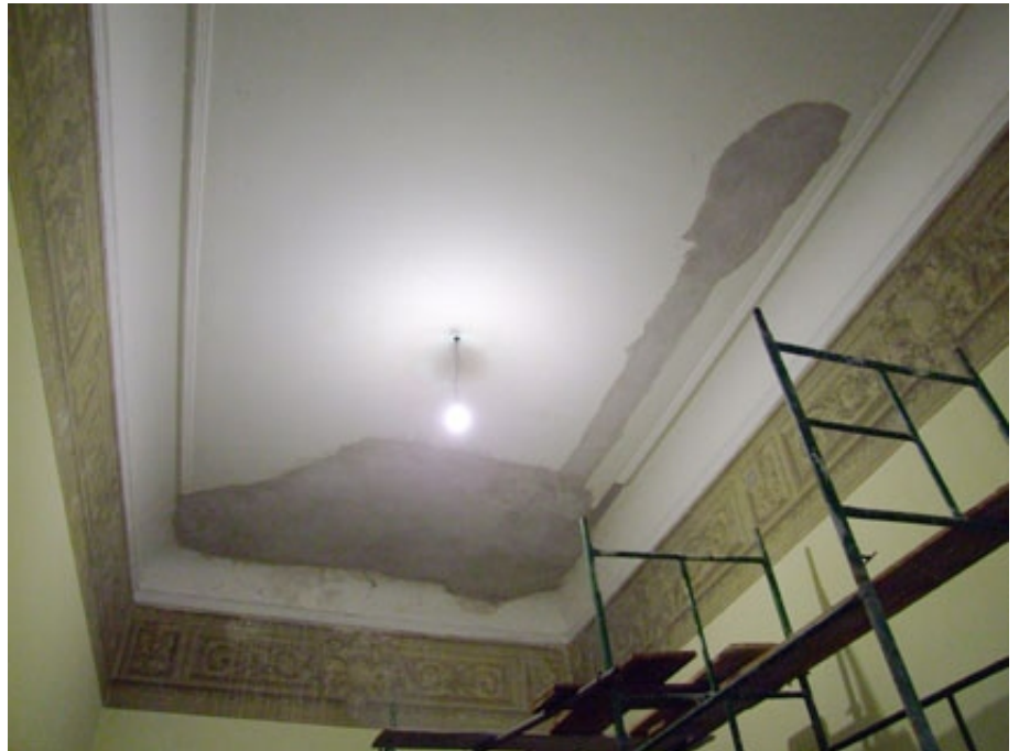
Despreendimento da argamassa solta e recuperação das trincas, com restauro da moldura de gesso.
