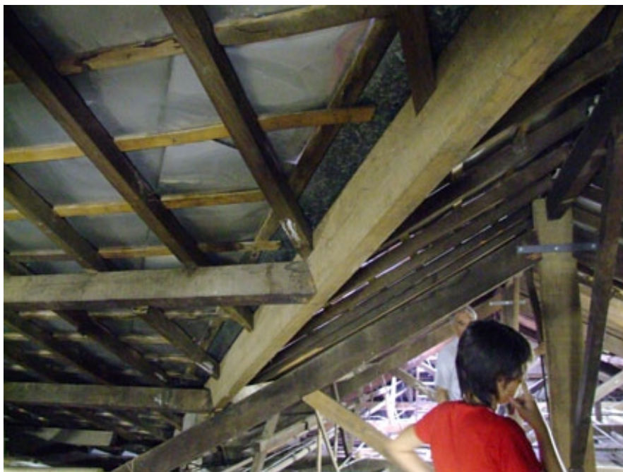
Substituição da viga sob água furtada entre as tesouras T7 e T8.
