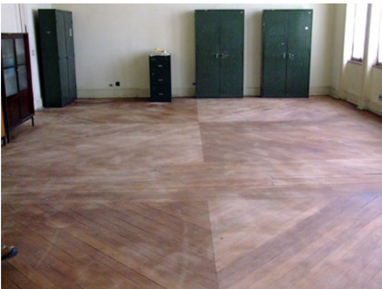
Remoção de resíduos e limpeza dos pisos de madeira.
