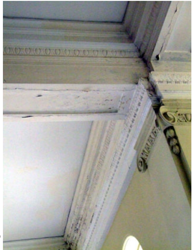
Limpeza e pintura das molduras do teto do corredor.
