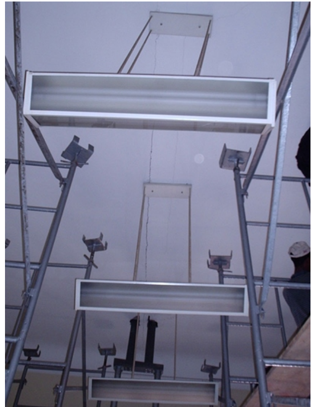
Trincas existentes no forro antes do reparo.
