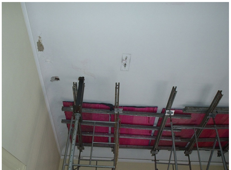
Aspectos de deterioração do forro, antes de ser reparado.
