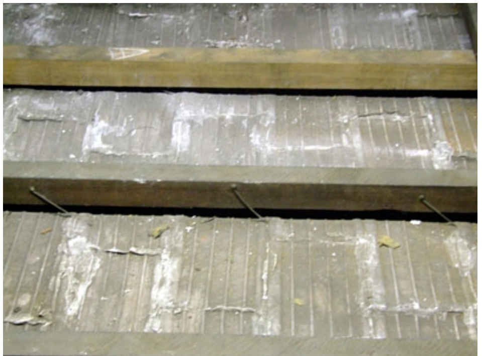
Grampo de aço de fixação das lajotas cerâmicas do forro.
