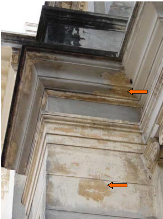
Cor da segunda camada de repintura de tom amarelo forte.
