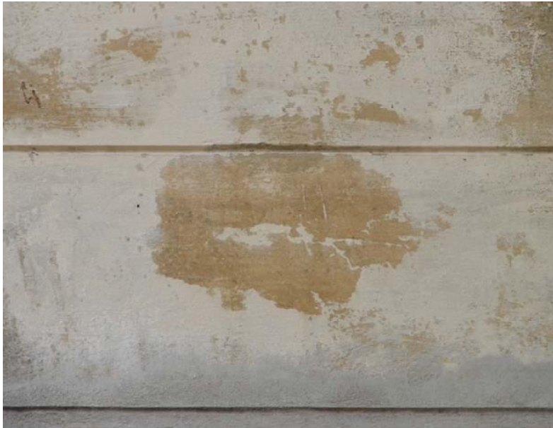
Observe a impregnação da segunda camada de pintura na argamassa.
