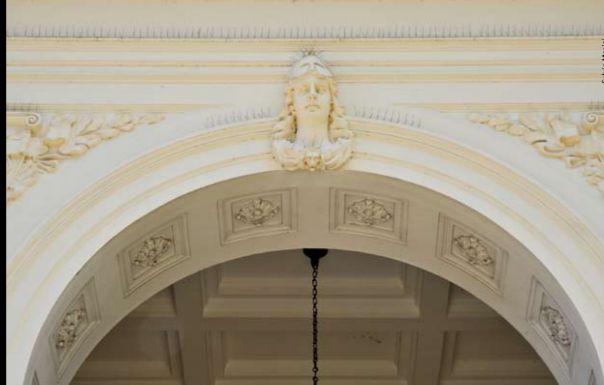
Detalhe da fachada do Edifício Ramos de Azevedo
